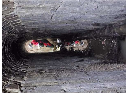
Souterrains de Revel (BL, 21/10/2025)
